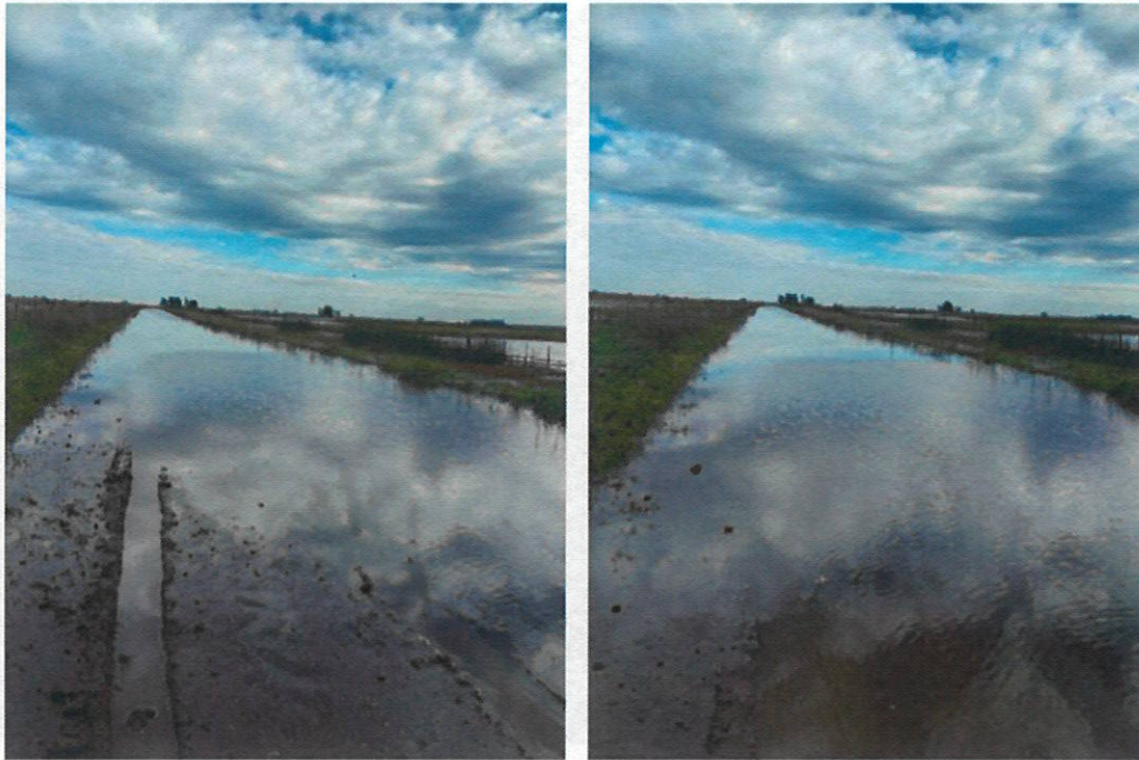
Imagen 4 - Estado de los caminos de acceso a la zona de obras
